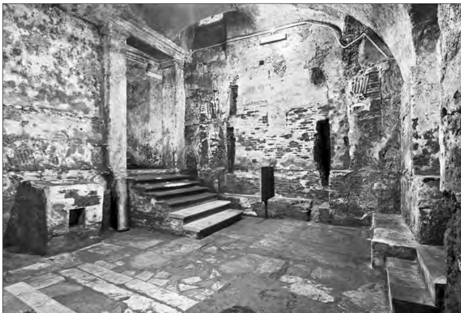
Fig. 2. - S. Maria in via Lata. Sotterranei della chiesa. Vano II.
