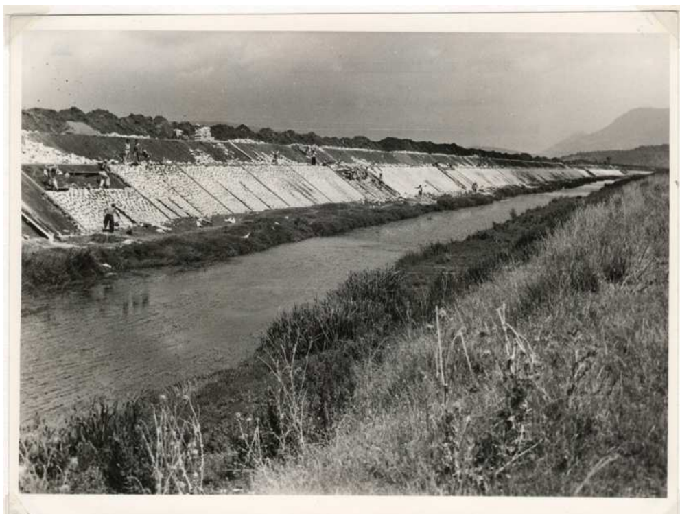
[11] Sistemazione del fiume Amaseno, in sponda sinistra, dopo eseguito lo scavo di ampliamento, si esegue il lavoro di rivestimento della sponda, con murature di pietrame e malta, 1953
