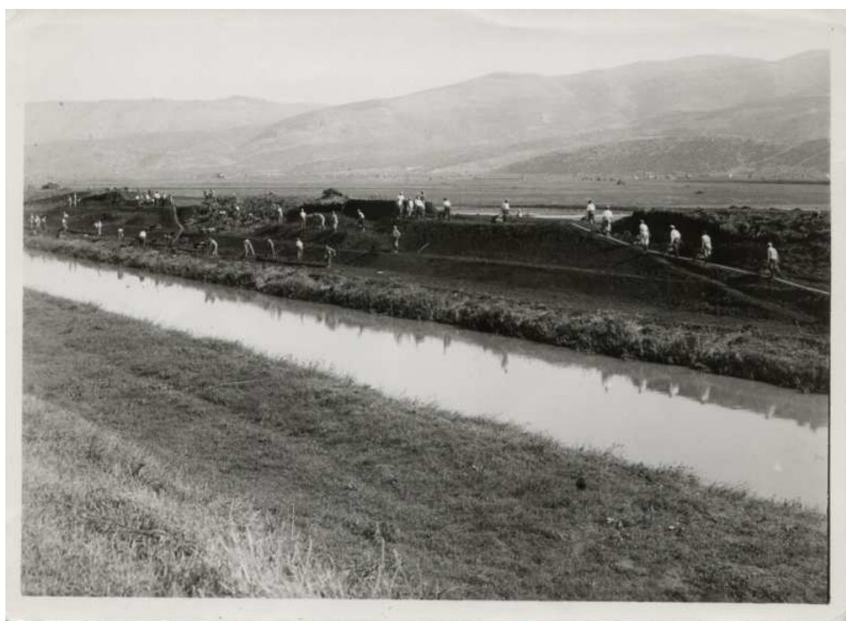
[9] Fiume Amaseno (piena del 10 ottobre 1936) riparazione delle due rotte aperte, 600 metri a monte della strada 55, riva sinistra, 1936
