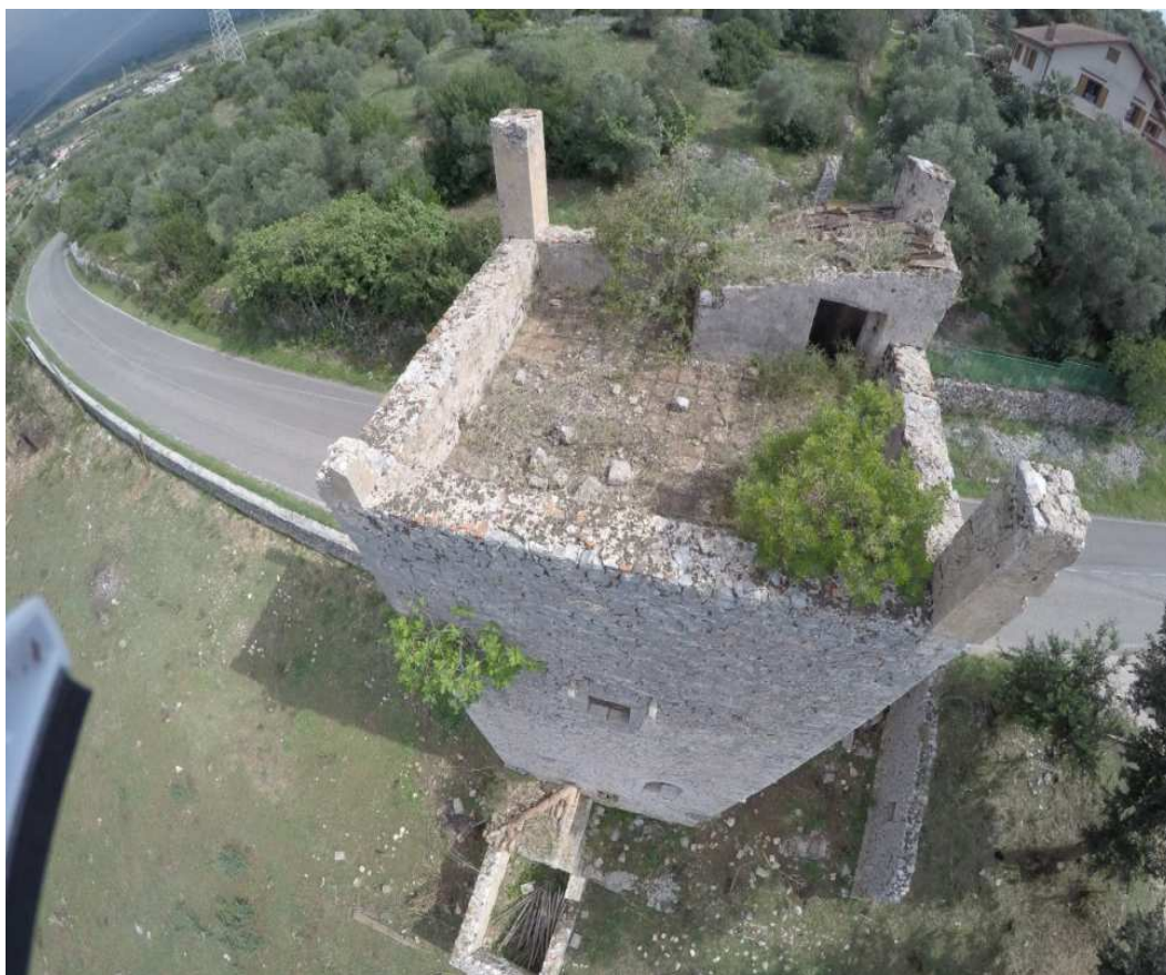
Figura 59. Torretta Rocchigiana vista dall'alto mediante rilevazione topografica con drone. Rilievo e fotografia dell'autrice, 2022
