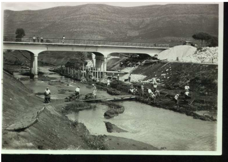
[8] Fiume Amaseno. Sistemazione dell'alveo a valle del ponte di Fossanova e costruzione del rivestimento – briglia sotto il ponte, 1932
