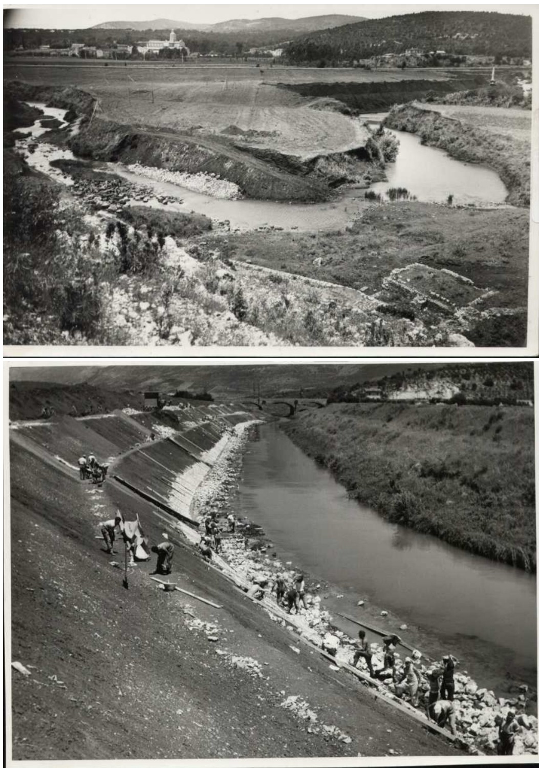
Figure 36 e 37. Fiume Amaseno. Sistemazione dell'alveo a valle del ponte di Fossanova e costruzione del rivestimento – briglia sotto il ponte, 1932, CBP, Sottoserie Fotografie I
