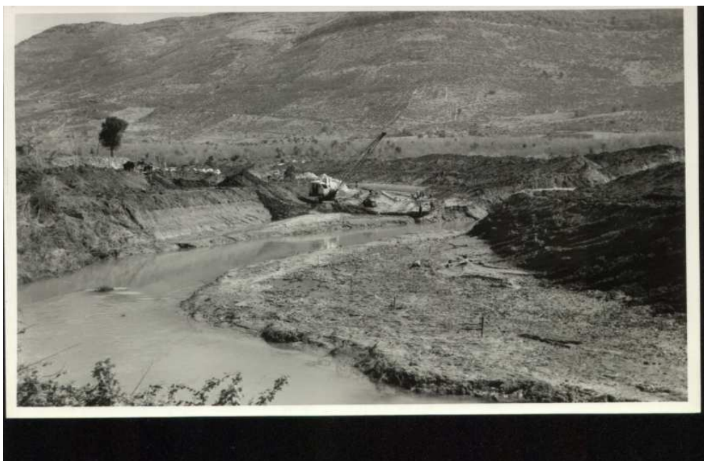
[12] Sistemazione del fiume Amaseno dal ponte di Fossanova alle Mole dell'Abbadia. Impresa A. Zaccardi di Roma. Lavori di sistemazione dell'alveo mediante escavatori, 1958
