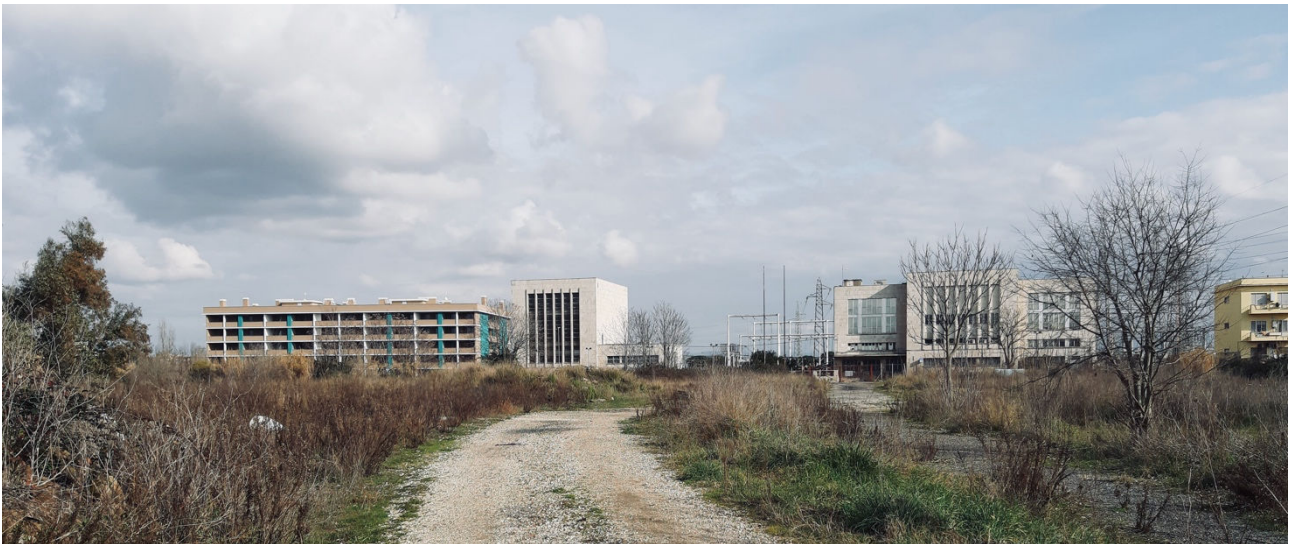
Fig. 11. Anello verde, edifici industriali e residenze, via del Flauto.
