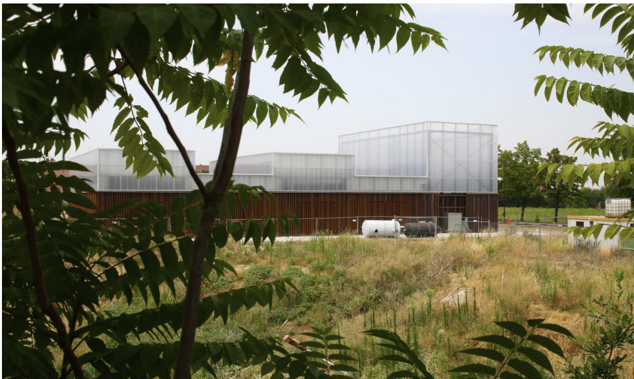
Figura 3. SIN di Fidenza: Centrale di cogenerazione installata nell'area di bonifica. Fonte: Comune di Fidenza, 2019.
