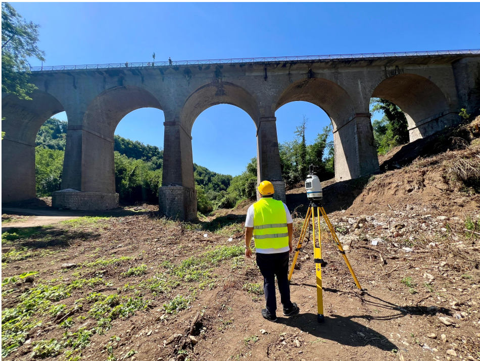
Figure 5.17: Position n.1 of Laser Scanner
