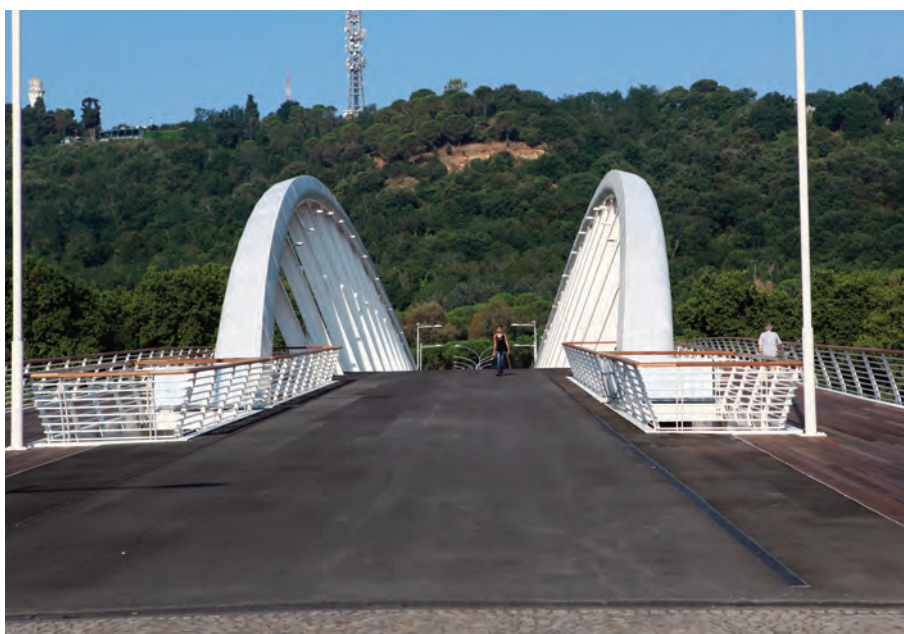
Due archi di sezione variabile e fortemente inclinati verso l'esterno separano la carreggiata centrale dai due percorsi pedonali laterali (Mario Petrangeli e Associati Srl, Studio Associato Biggi Guerrini).
