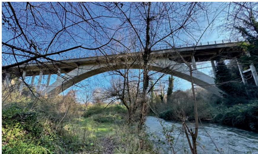
Fig. 3. Il nuovo ponte in cemento armato, costruito negli anni Sessanta del Novecento, si innesta nel paesaggio fluviale sovrastando l'antico tracciato (foto Sara Carallo).
