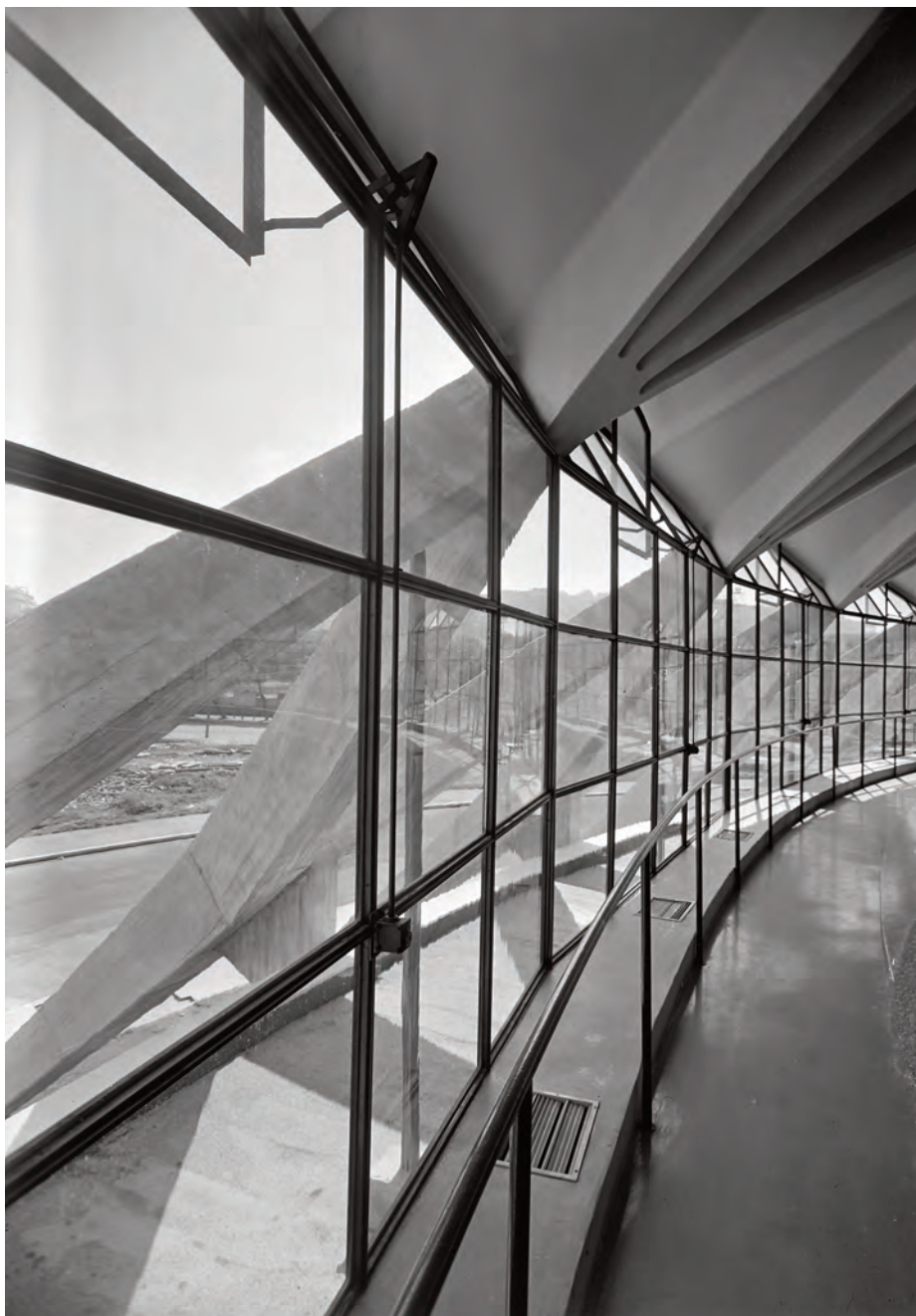
Il deambulatorio perimetrale interamente vetrato (MAXXI CA, Fondo Pier Luigi Nervi).
