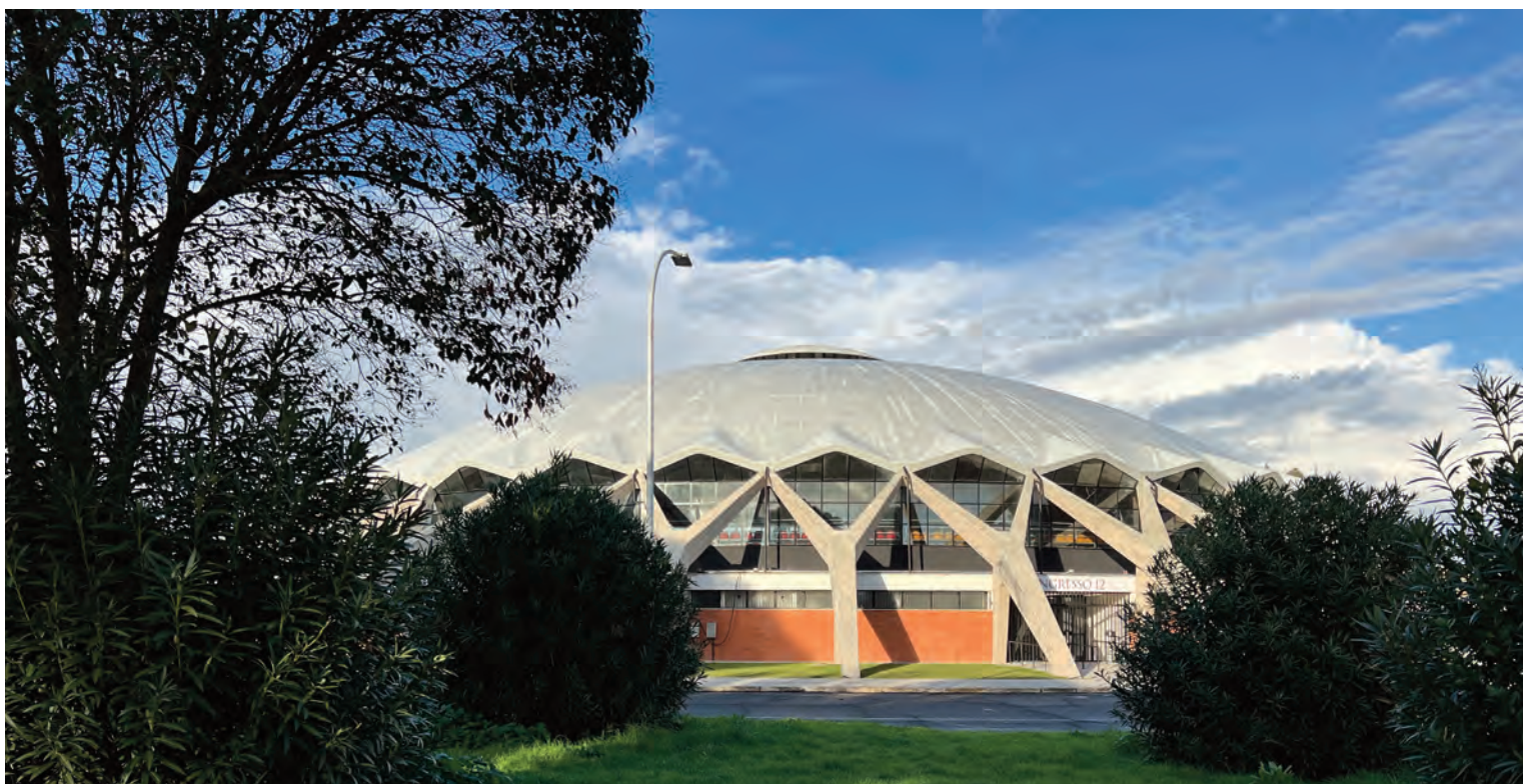
Il Palazzetto dello Sport dopo i recenti lavori di rinnovamento (Foto Rosalia Vittorini).
