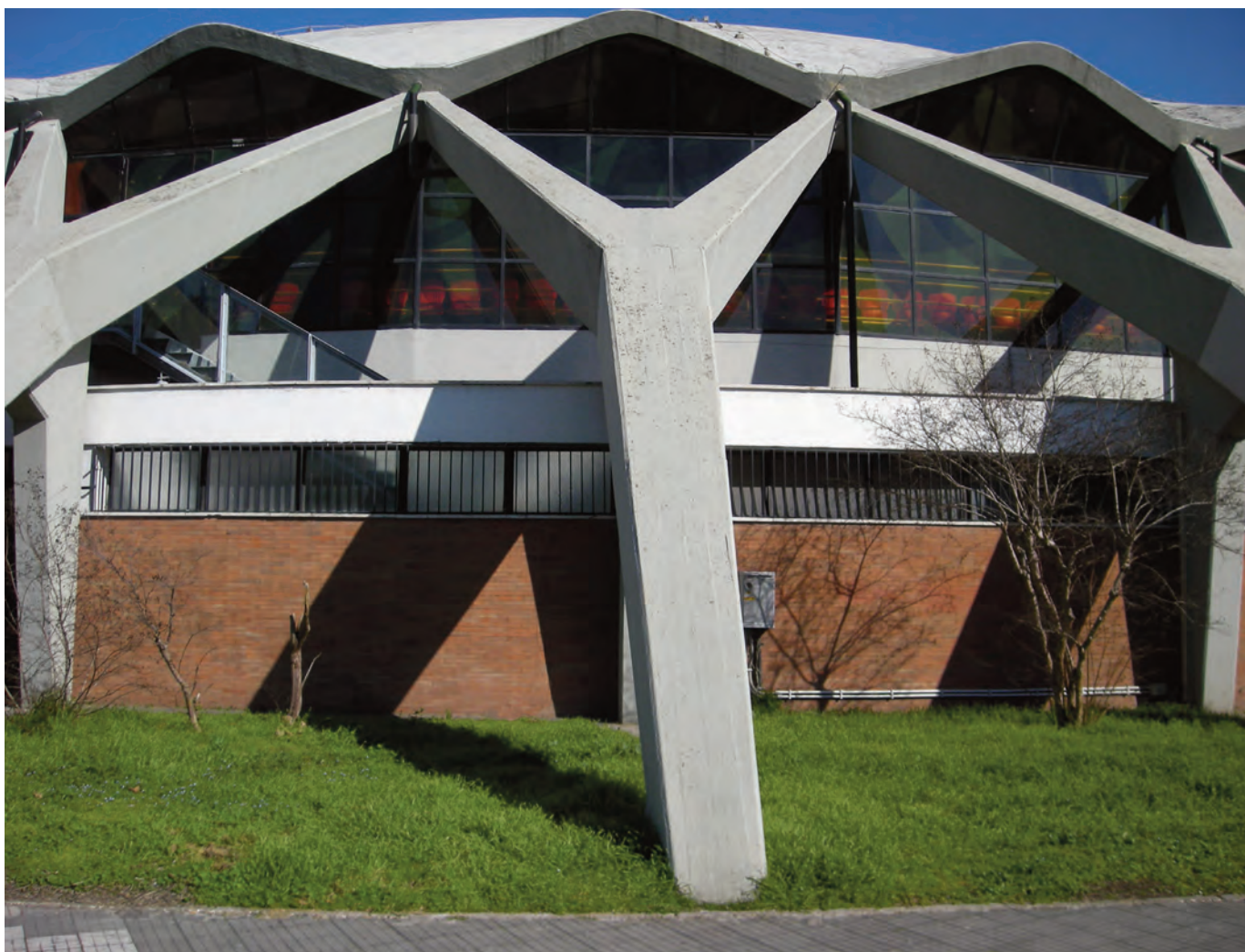
Particolare di uno dei cavalletti inclinati a forma di Y a sostegno della cupola (Foto María Margarita Segarra Lagunes).
