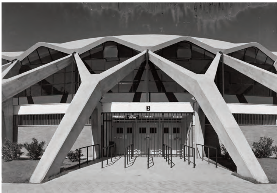
Realizzazione della cupola nervata col montaggio degli elementi prefabbricati prima del getto delle nervature. Sotto, uno degli ingressi al Palazzetto, già completato (MAXXI CA, Fondo Pier Luigi Nervi).
