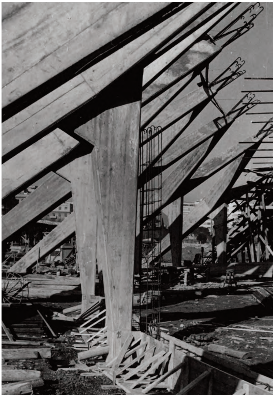
Costruzione dei cavalletti inclinati a forma di Y che costituiscono l'appoggio della cupola (MAXXI CA, Fondo Pier Luigi Nervi).
