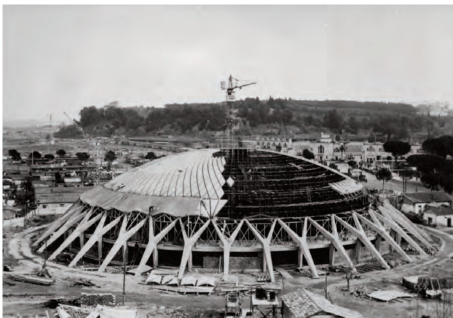
Fasi costruttive del Palazzetto: realizzazione della corona di cavalletti a forma di Y e montaggio della cupola nervata (MAXXI CA, Fondo Pier Luigi Nervi).
