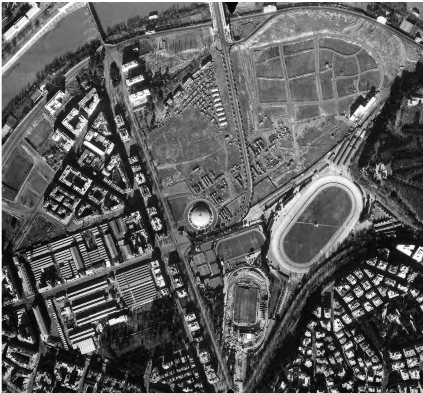
Fotografia aerea del 1958 che documenta i lavori in corso nell'ansa del fiume, in vista delle Olimpiadi del 1960: al centro, il Palazzetto dello Sport di Pier Luigi Nervi e Annibale Vitellozzi; in basso, il nuovo Stadio Flaminio in costruzione e, in alto, il primo tracciato del Villaggio Olimpico (ICCD, Aerofototeca nazionale).
