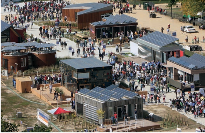
Fig. 2 – Il Solar Village a Washington DC US nel 2009, dove 20 università selezionate in tutto il mondo assemblano e fanno funzionare altrettanti prototipi di case, alimentati dall'energia solare e connessi tra loro in una rete smart .
