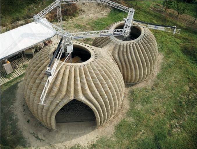
Fig. 5 – Fase della stampa 3D in terra cruda locale di TECLA, Technology and Clay , un’abitazione sostenibile, che risponde alla sempre più impellente emergenza climatica, al bisogno di abitazioni sostenibili a km 0 e al grande tema globale dell’emergenza abitativa cui si dovrà fare fronte, specie nei contesti di crisi generati dalle grandi migrazioni o da catastrofi naturali. Il progetto di Mario Cucinella Architects, realizzato da WASP (World’s Advanced Saving Project), evoca il forte legame tra passato e futuro unendo la materia e lo spirito di antiche dimore senza tempo con il mondo della produzione tecnologica del XXI secolo.
