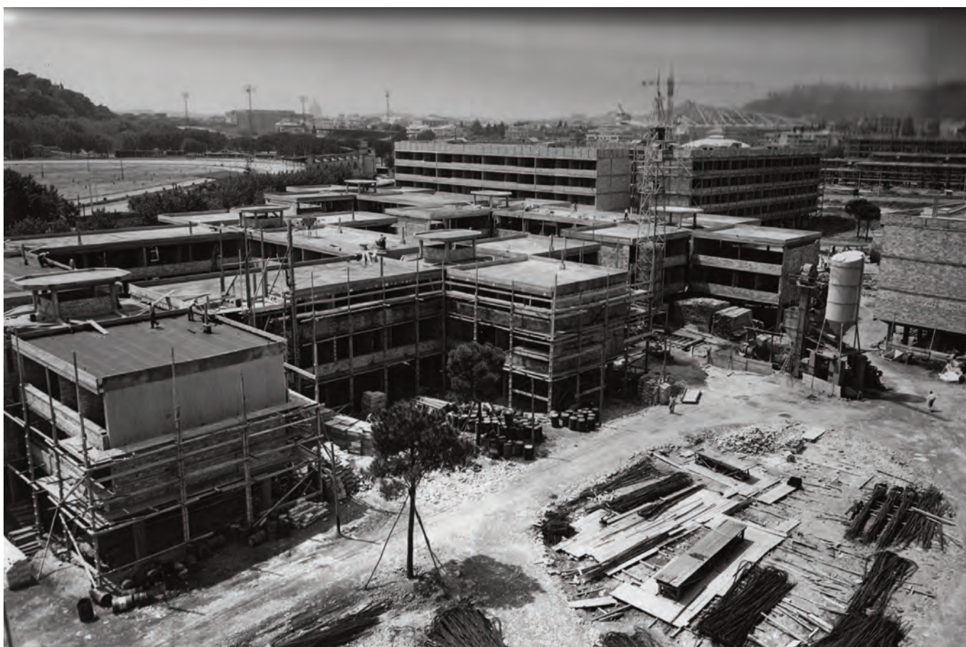
Il Villaggio Olimpico in costruzione (Archivio Rosalia Vittorini).
