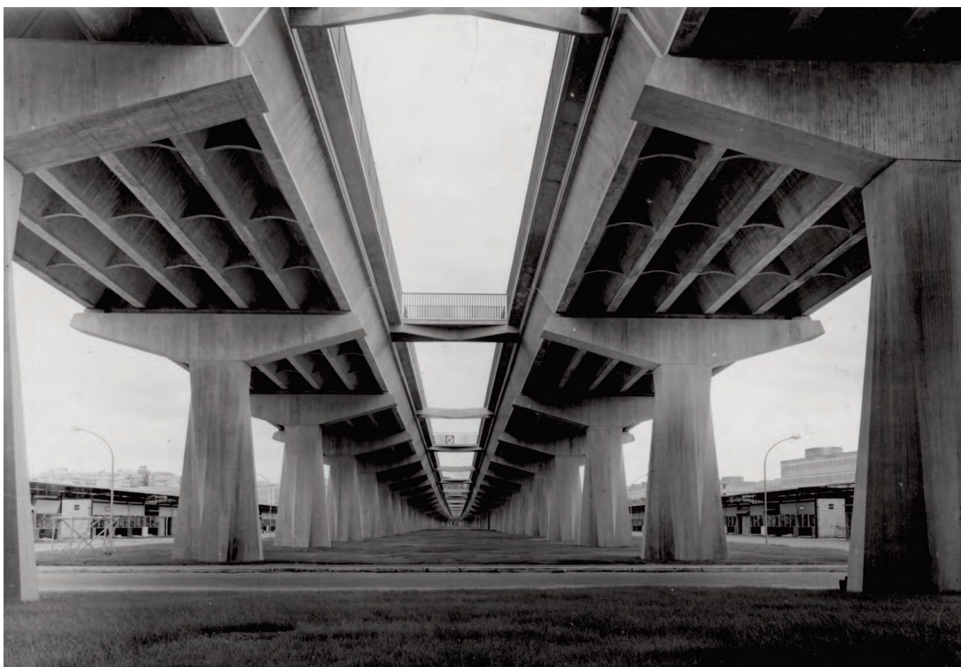
Il Viadotto già completato in una fotografia d'epoca (MAXXI CA, Fondo Pier Luigi Nervi).
