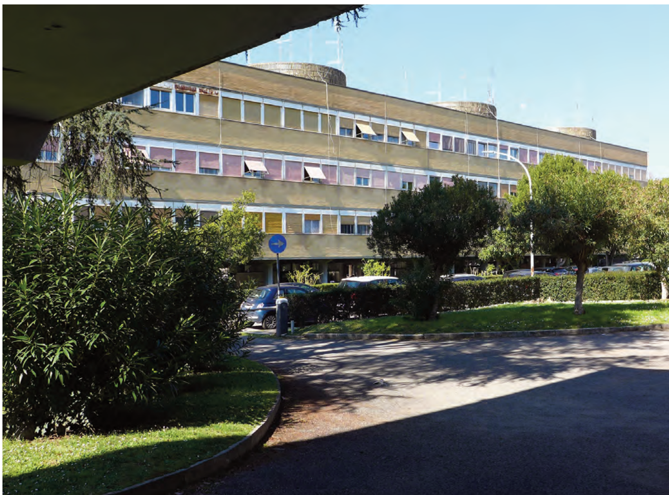
Uno degli edifici in linea del Villaggio Olimpico, oggi (Foto María Margarita Segarra Lagunes).
