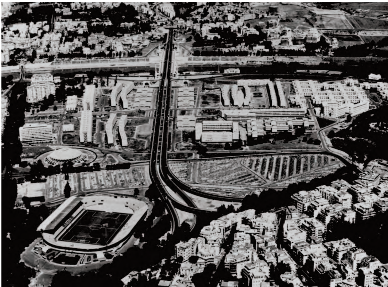
Il Viadotto nel contesto urbano in una fotografia degli anni Sessanta. Sulla sinistra si riconosce lo Stadio Flaminio, il Palazzetto dello Sport e il Villaggio Olimpico; a destra, l'altra porzione del Villaggio Olimpico (MAXXI CA, Fondo Pier Luigi Nervi).
