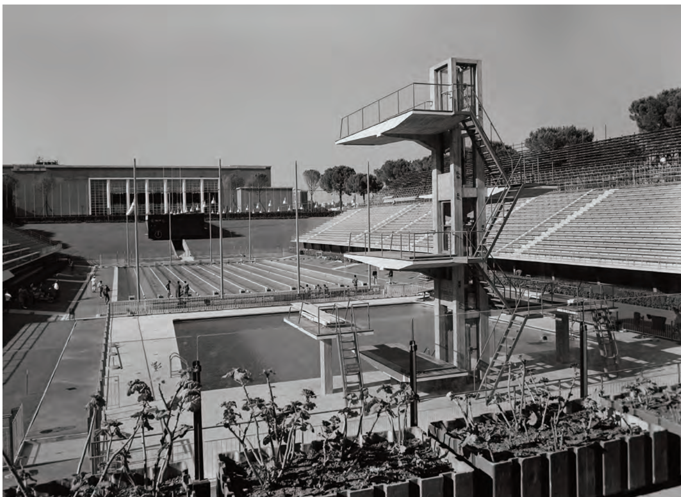
L'area di gara comprende la grande piscina olimpionica e la vasca più profonda per i tuffi, disposte in sequenza tra le tribune che ospitano, al di sotto, gli spogliatoi e i servizi per gli atleti (ICCD, Fondo Oscar Savio).
