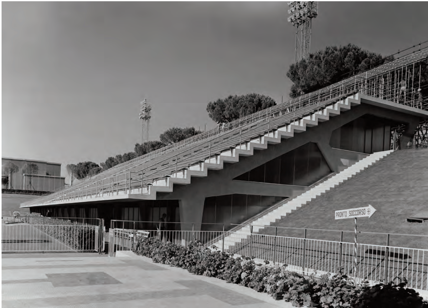
Le tribune, che sembrano sospese su pochi appoggi, ospitano, al di sotto, tutti i servizi (ICCD, Fondo Oscar Savio).
