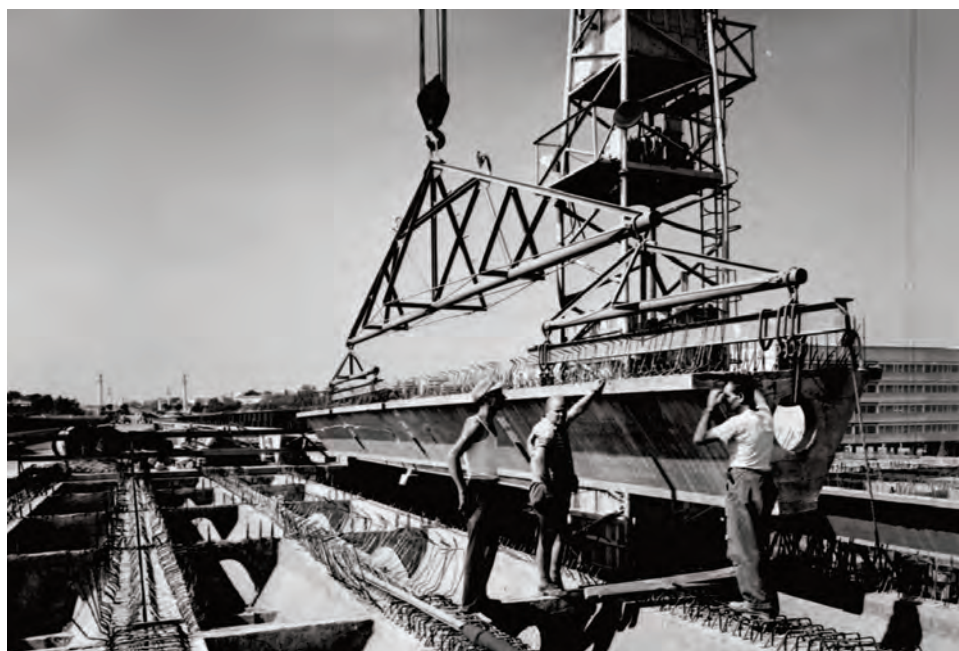
Fasi della costruzione del Viadotto: posizionamento delle travi sui pilastri (MAXXI CA, Fondo Pier Luigi Nervi).
