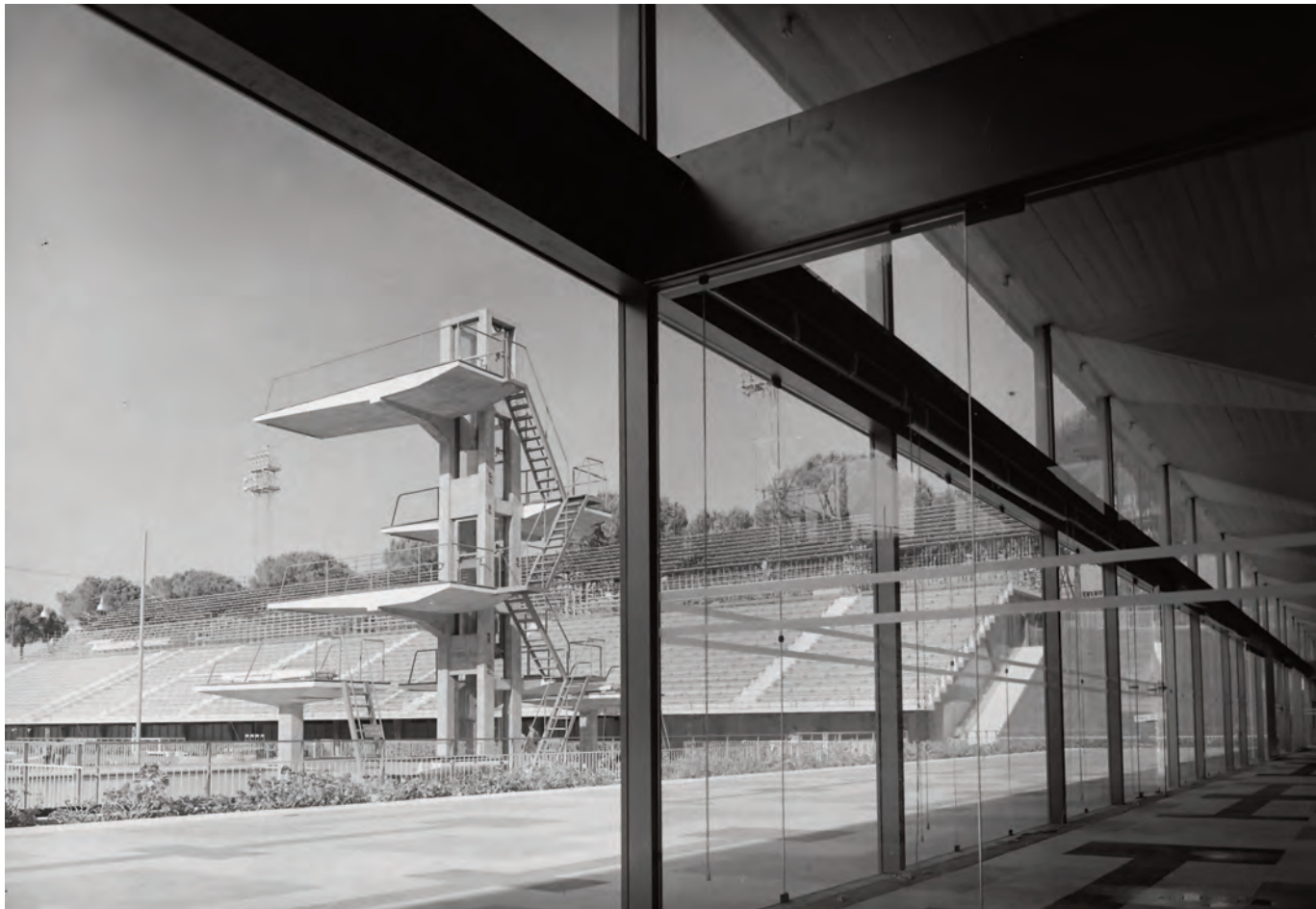
Il trampolino visto dall'edificio dei servizi comuni con la copertura pieghettata in cemento armato progettata dall'ingegnere Sergio Musmeci (ICCD, Fondo Oscar Savio).
