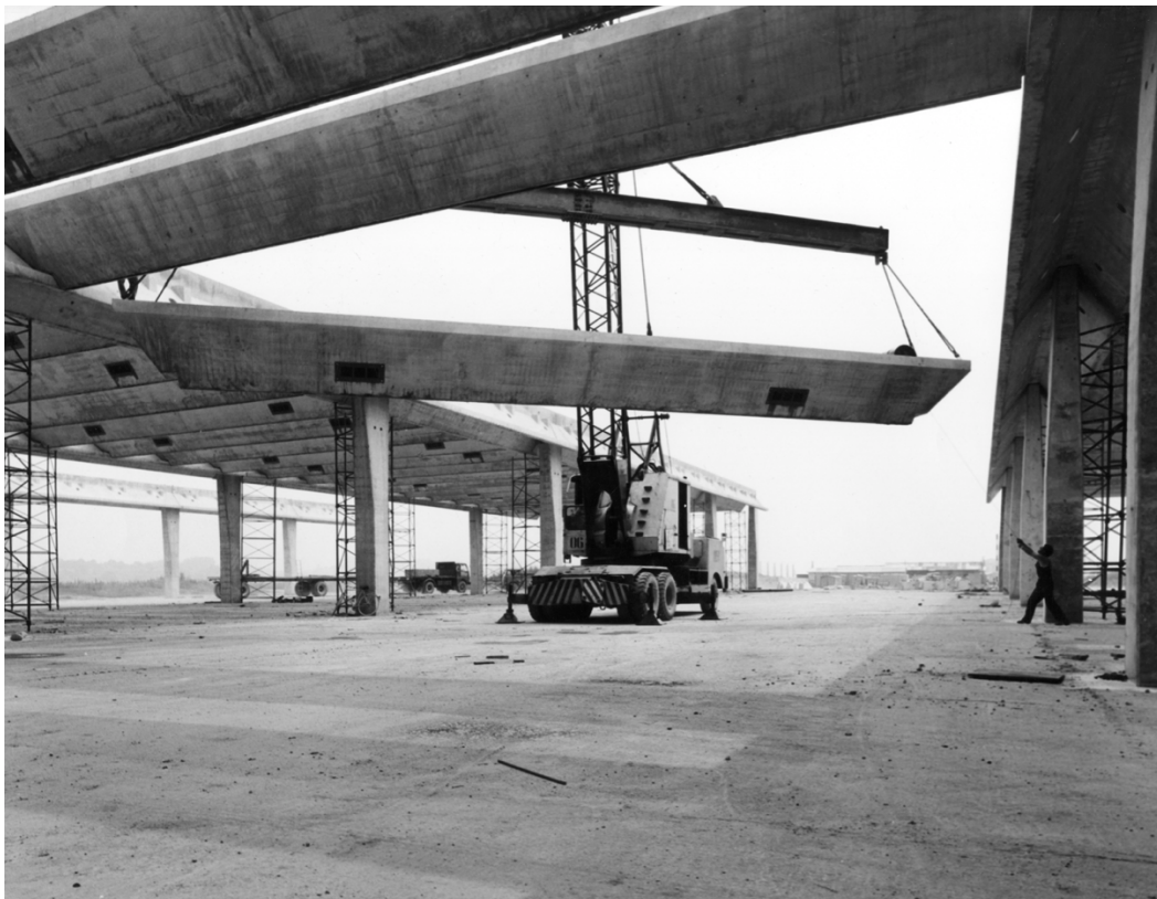
Fotografie delle fasi di assemblaggio delle strutture del “Sistema Olivetti Italia”: posa dei pilastri, posa delle travi principali, trasporto e posa in opera delle travi secondarie. Stampe fotografiche (AdM, MZ A FOT S37)
