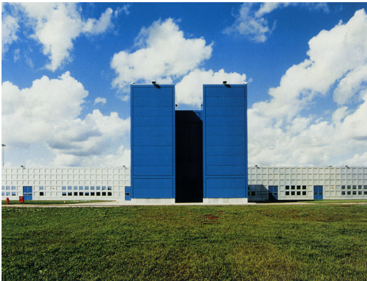
Vista esterna dello stabilimento in uno scatto di Matteo Piazza. Stampa fotografica (AdM, MZ A FOT S47)
