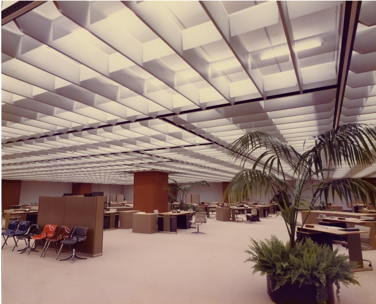
Veduta dell'interno dello spazio per uffici. In questo punto, corrispondente ad un angolo dell'edificio, le trame uniformi dei controsoffitti si intersecano secondo un tracciato scalare. Stampa fotografica (AdM, MZ FOT A S217)
