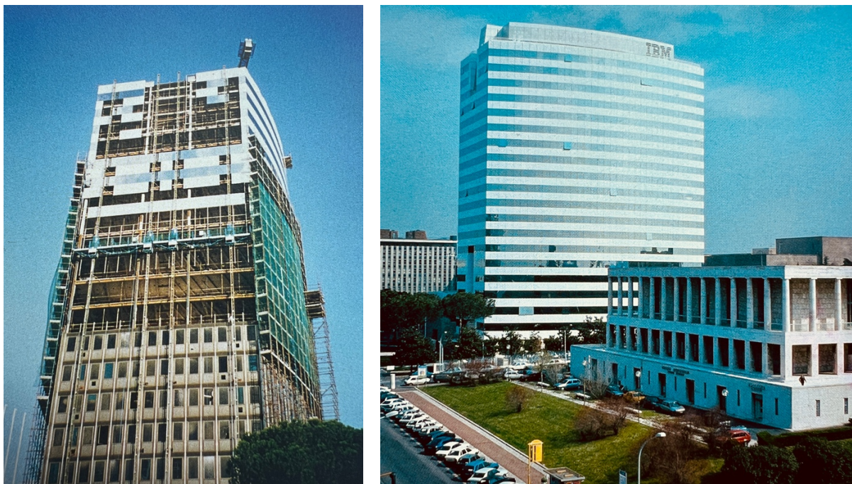
Vedute della torre IBM durante l'operazione di "recladding" (da: P.A. Croset, L. Skansi, Modern and Site Specific. The Architecture of Gino Valle, 1946-2003, Londra, Lund Humphries, 2018, p. 255) e a costruzione conclusa (da: P.A. Croset, L. Skansi, Gino Valle, Milano, Electa, 2010, p. 255)
