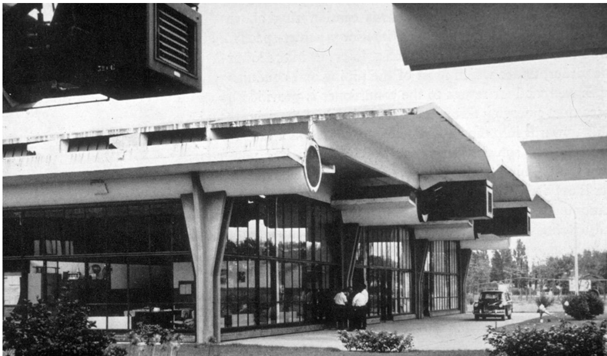
Veduta della fabbrica Olivetti a Merlo, Buenos Aires, progettata da Marco Zanuso nel 1954-1961
