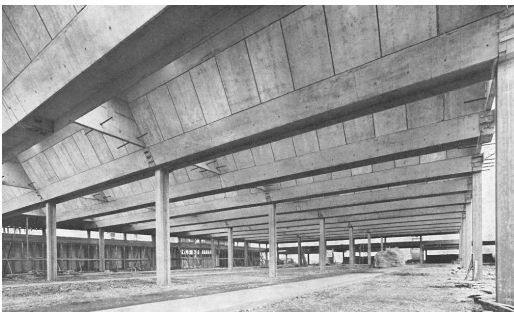
Vedute della struttura prefabbricata per lo stabilimento FIRGAT durante la costruzione. Si noti, nella prima immagine, l'efficace effetto di "sospensione" conferito alla trave secondaria, effettivamente sospesa sulle strette travi principali. (Da: A. Migliasso, S. Nicola, Cubierta con elementos prefabricados de hormigón armado y pretensado, en Villanova de Asti, Italia in: "Informes De La Construcción" n. 215, vol. 22, novembre 1969, pp. 48, 55)
