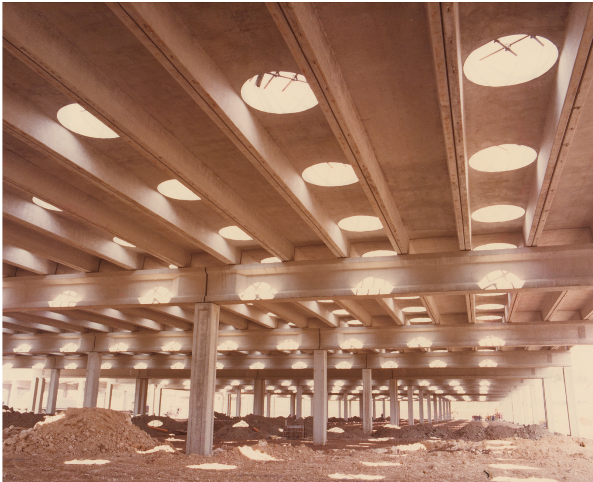
Vista della struttura portante in calcestruzzo prefabbricato durante la costruzione. Stampa fotografica (AdM, MZ A FOT S47)
