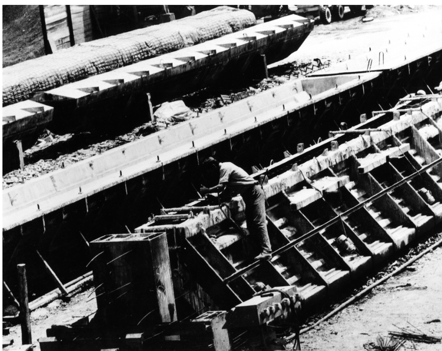
Calo di un'armatura preassemblata nel cassero per il getto di una trave principale e maturazione del getto con applicazione della precompressione nel cantiere di prefabbricazione foranea per la realizzazione dello stabilimento Olivetti di Scarmagno (TO). Stampa fotografica (AdM, MZ A FOT S37)
