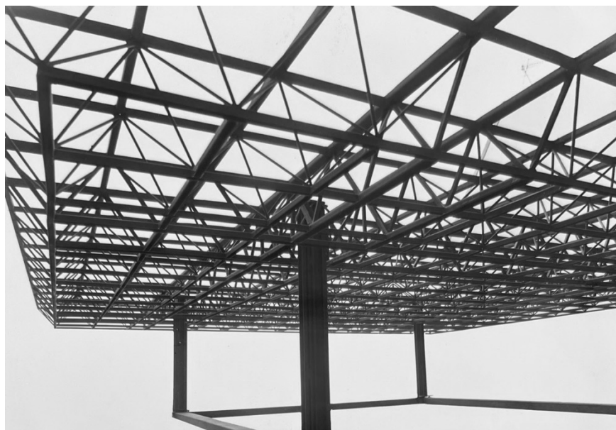
Modello della struttura reticolare in acciaio nel primo progetto per la fabbrica Olivetti a Scarmagno. Stampa fotografica (AdM, MZ A FOT S36)
