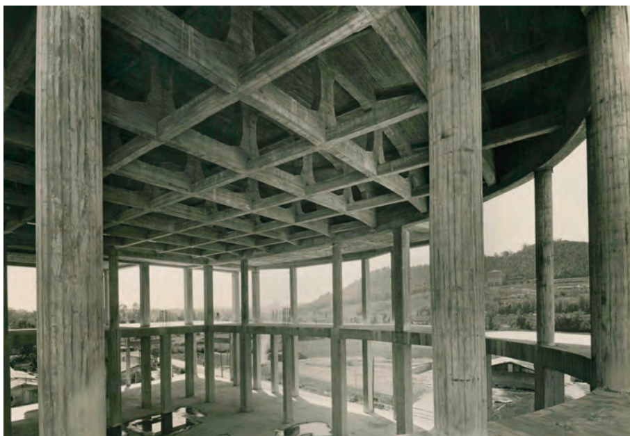
Accademia, in alto, struttura in cemento armato dell'Aula Magna e, in basso, del corpo curvo della palestra (MAXXI CA, Fondo Enrico Del Debbio).
