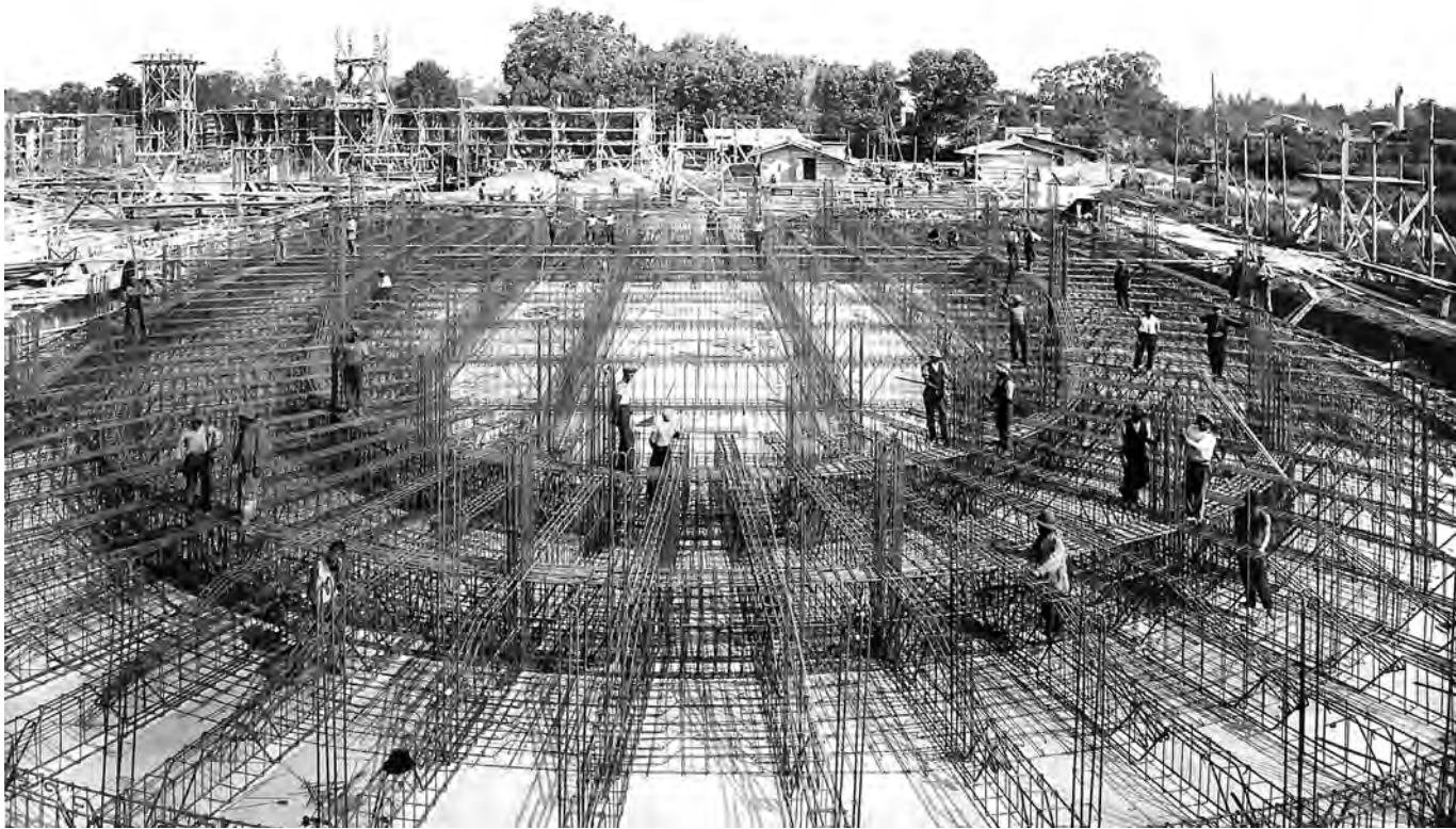
Armatura della struttura in cemento armato della Palestra (MAXXI CA, Fondo Enrico Del Debbio).
