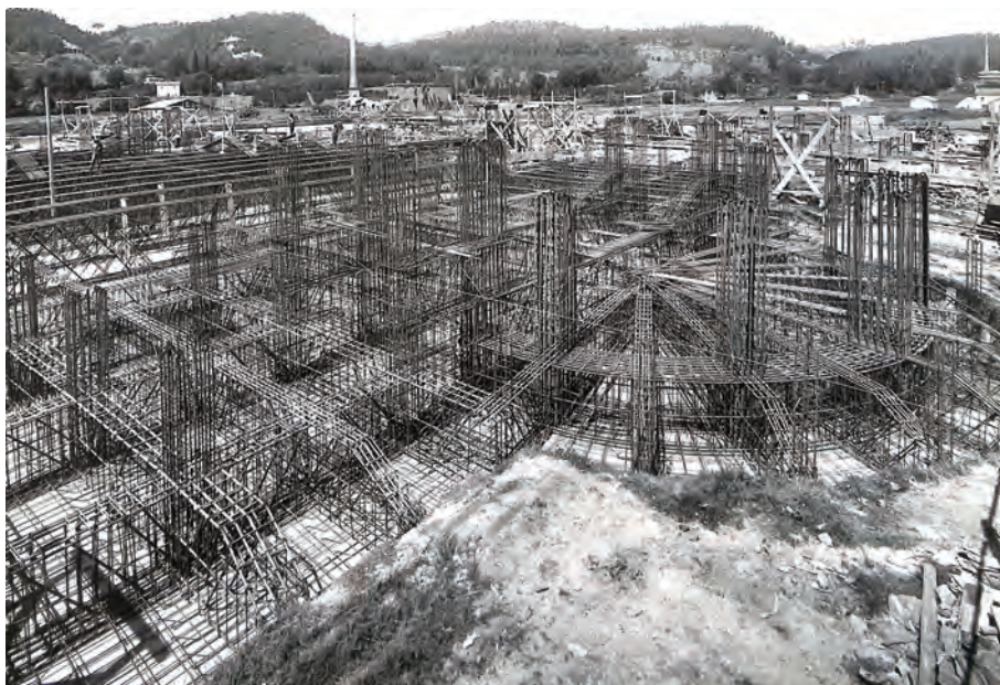
Armature della struttura di fondazione in cemento armato dell'Accademia di Educazione Fisica (MAXXI CA, Fondo Enrico Del Debbio).
