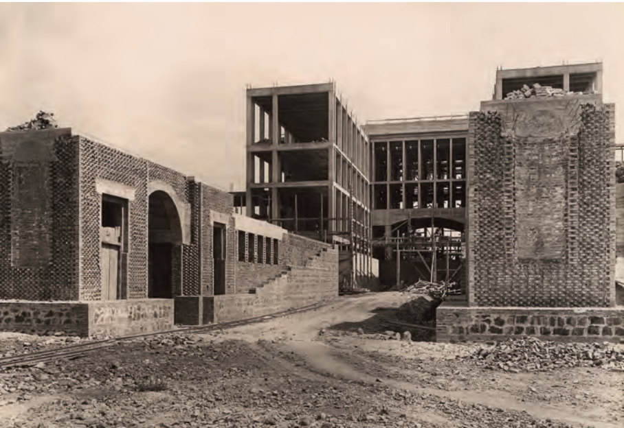
L'Accademia in costruzione: sullo sfondo si scorgono i telai in cemento armato con luci ridotte dell'edificio (MAXXI CA, Fondo Enrico Del Debbio).
