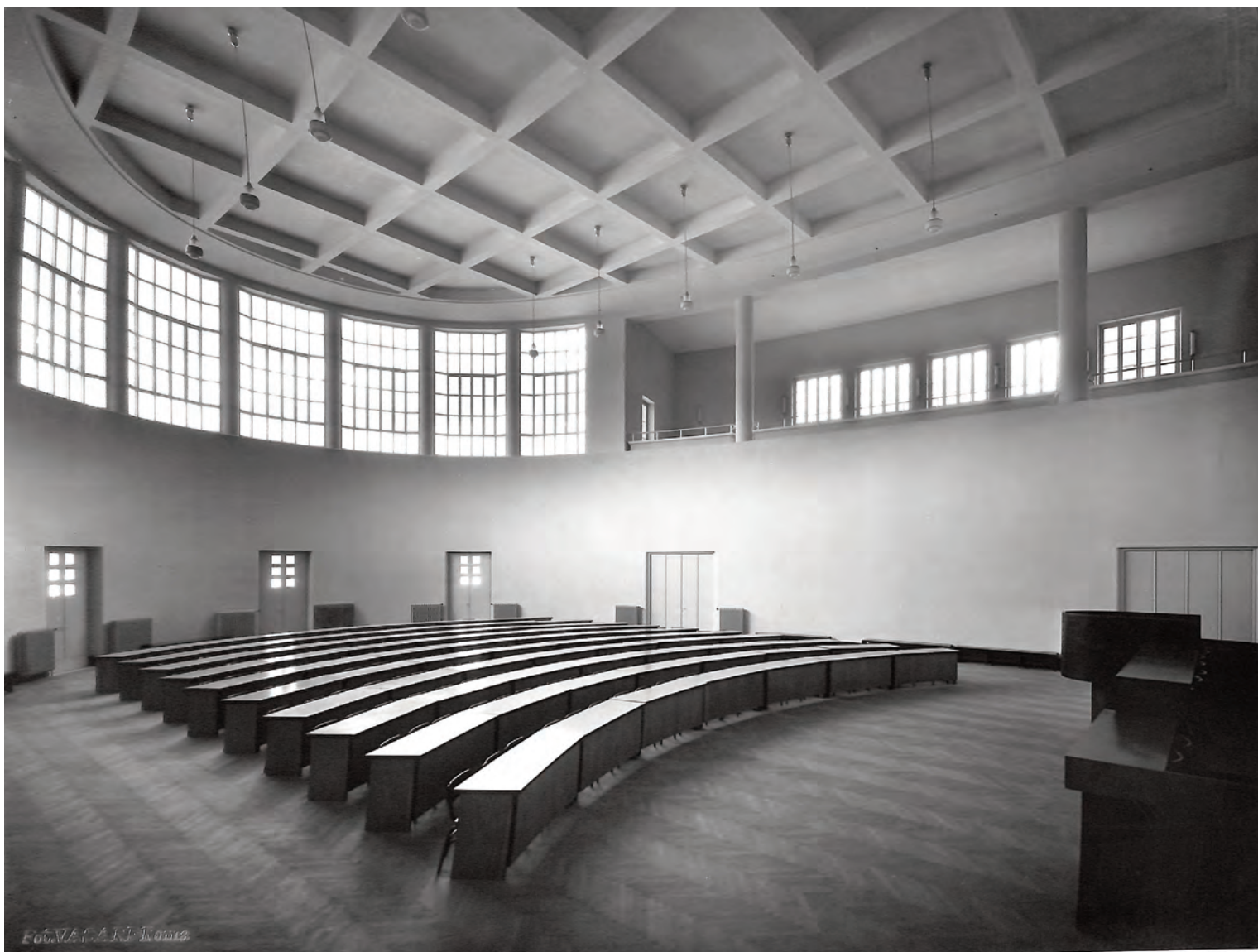
La Palestra con il soffitto a cassettoni che nasconde la struttura di travi Vierendeel (MAXXI CA, Fondo Enrico Del Debbio).
