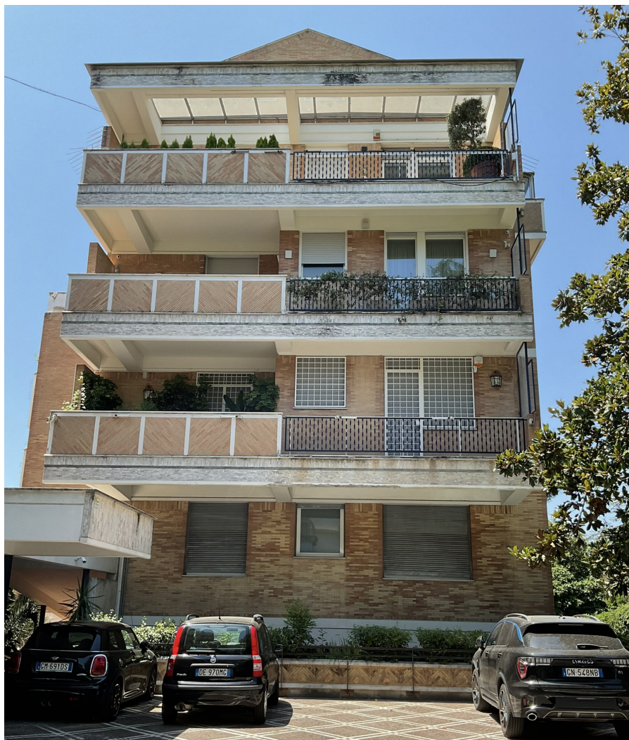
9.5 Villino a via Sebastiano Conca, Roma, 1960. Facciata interna, facciata esterna e dettaglio del coronamento su via Giuseppe Ceracchi, 38
