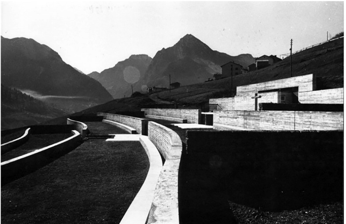
Fig. 10 Cimitero di Erto a Monte. L'interno, con la successione dei terrazzamenti per le sepolture a terra. L'andamento curvilineo dei muri di tenuta accompagna l'orografica del versante. L'Architecture d'Aujourd'hui 170 (1973).
