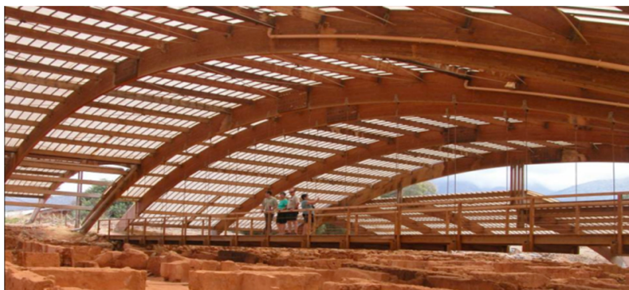
Malia (isola di Creta), Copertura degli scavi in legno lamellare e policarbonato
