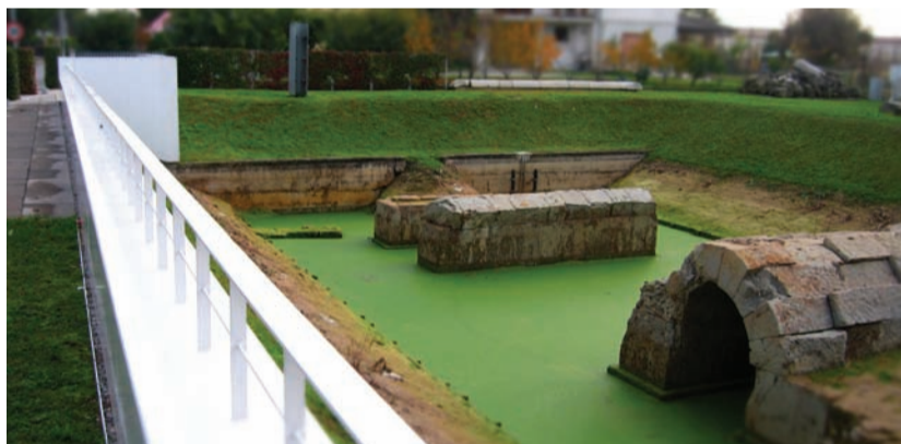
Concordia Sagittaria, Ponte romano, particolare
