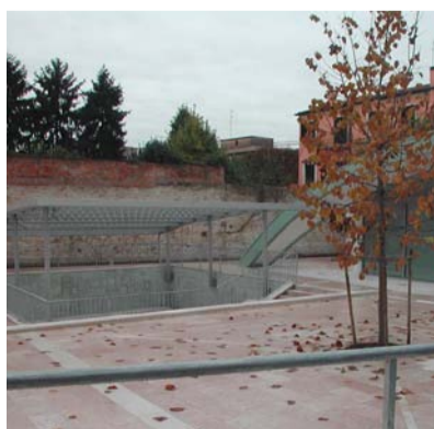
9 PADOVA Palazzo Maldura Copertura del recinto funerario
