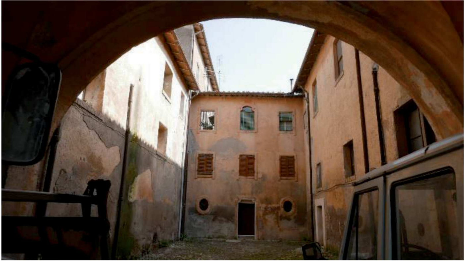
Fig. 6 – Casale di Castel di Guido, corte interna (foto G. Ortolani)
